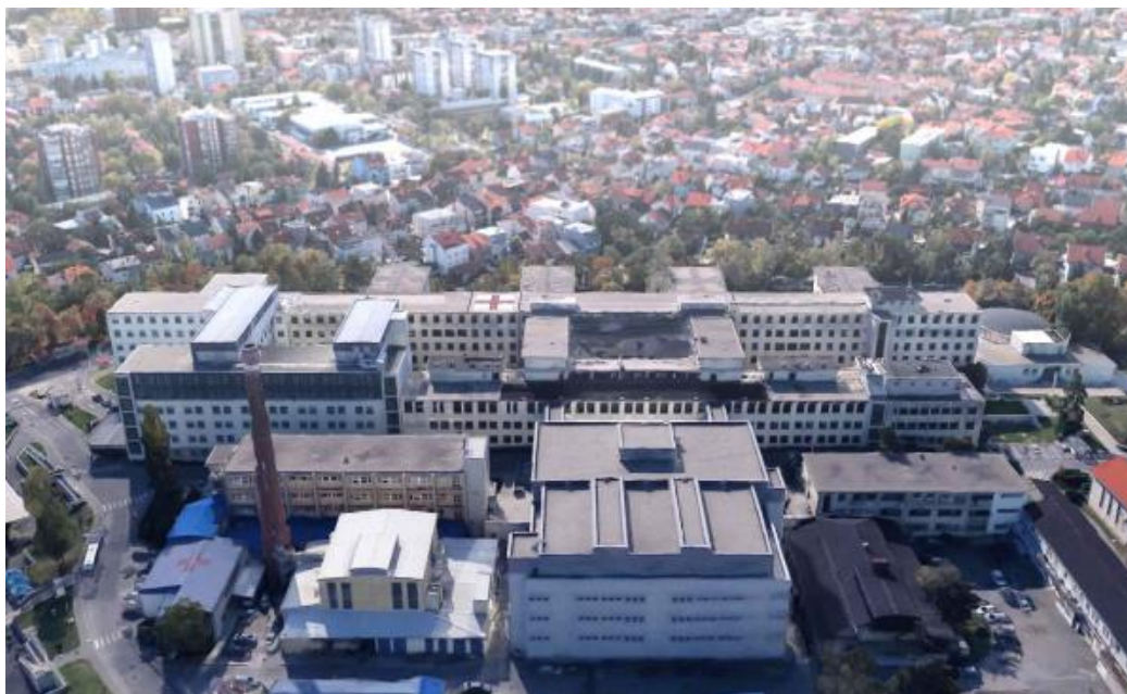
Slika 4. Postojeće stanje glavne zgrade
